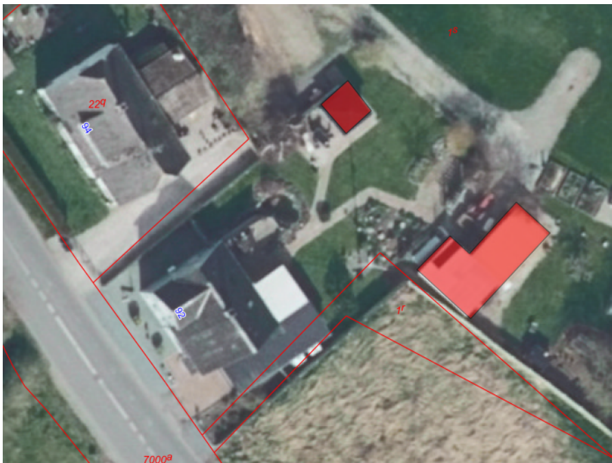
Figur 1: Luftfoto. Den røde markering viser de bygninger som ønskes lovliggjort.
