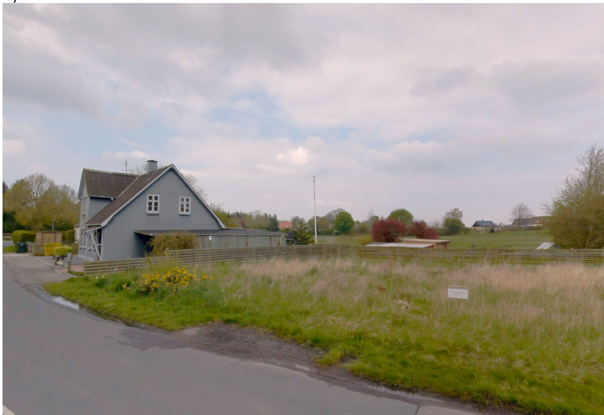
Figur 2: Gadefoto af ejendommen. Det lave udhus ses centralt til højre i billedet.
